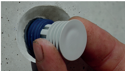
Positioneer de Sealing Plug in de afstandhouder
